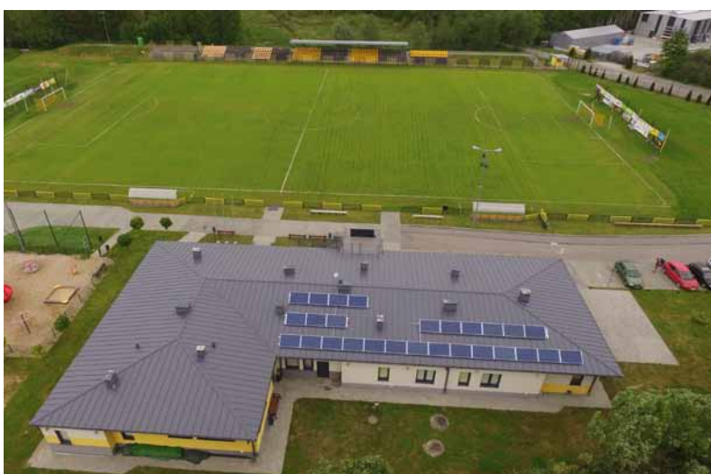
Świetlica Środowiskowa w Połańcu – 27 paneli o mocy maks. 275 W każdy
